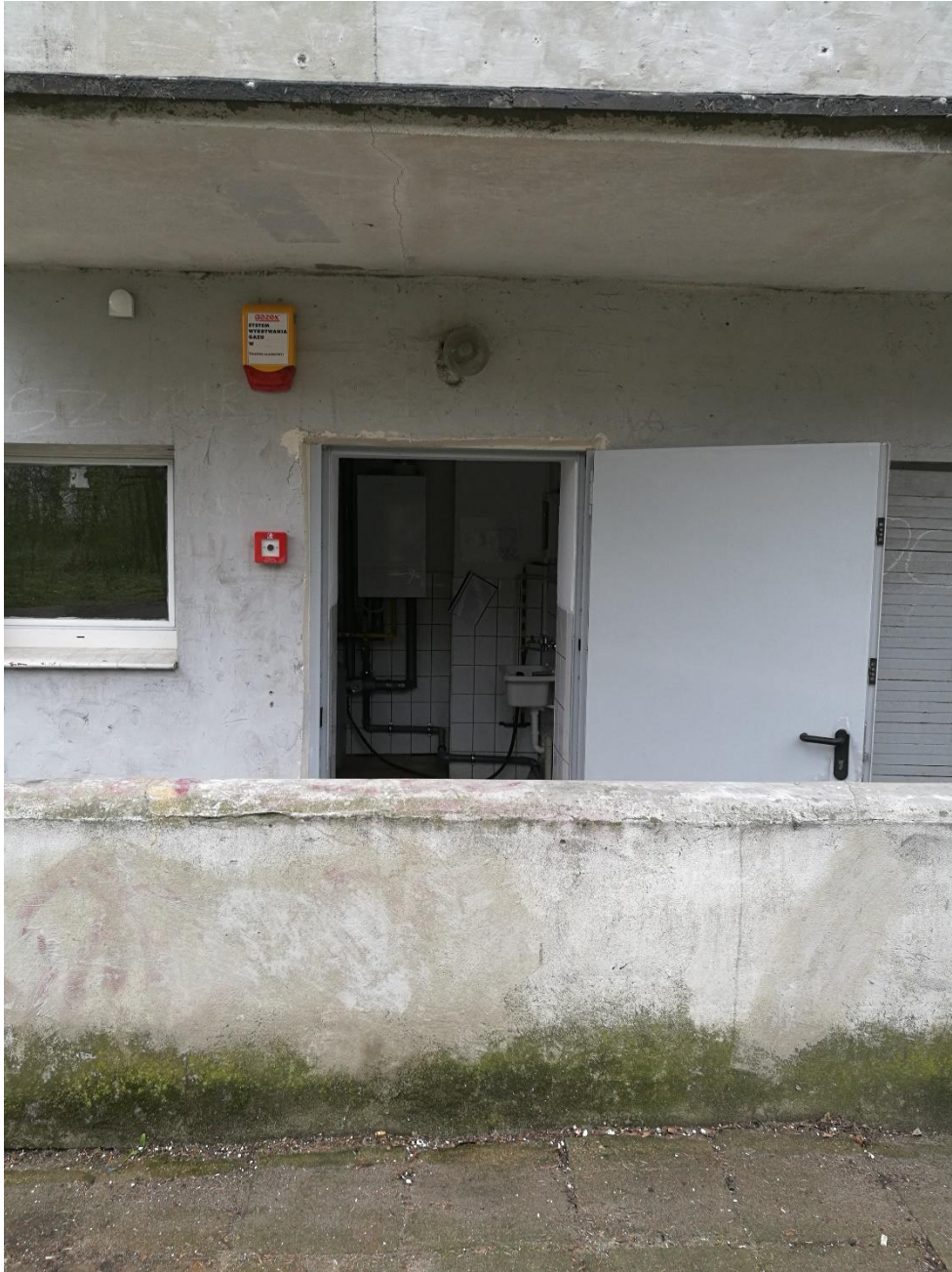
fot. 4 Wyjście z kotłowni – na pierwszym planie murek wymagający częściowej rozbiórki i odtworzenia w celu wyniesienia zbiorników
